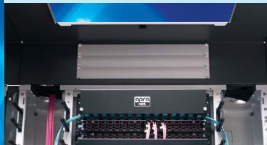
Vista interior del canal de refrigeración
