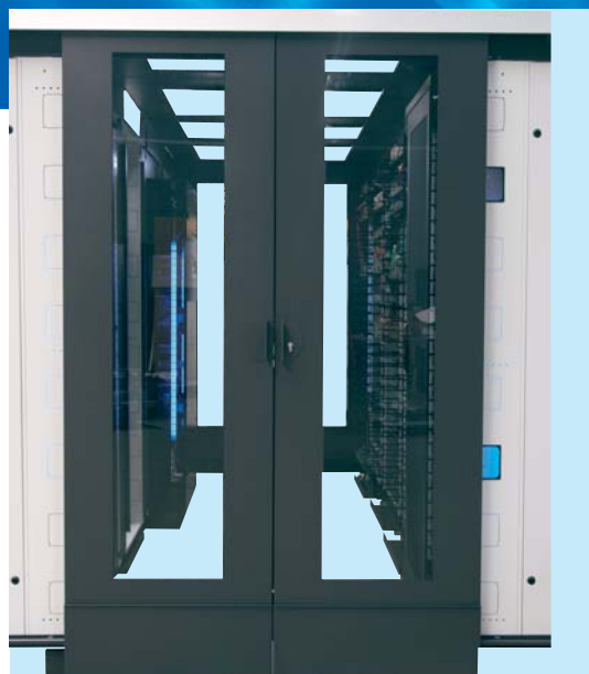
Vista interior del canal de refrigeración
